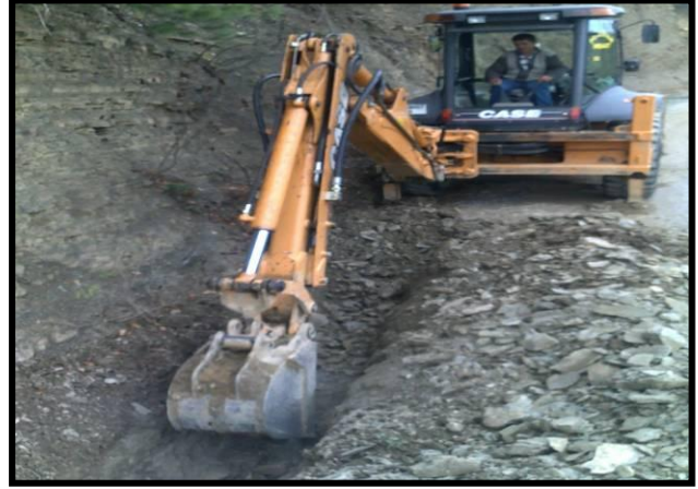
İçmesuyu Kanal Kazısı Çalışmaları
