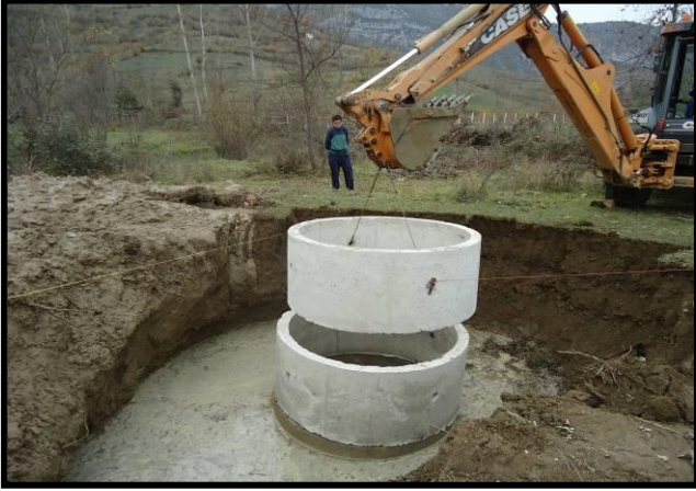
İçmesuyu amaçlı Keson kuyu Çalışmaları
